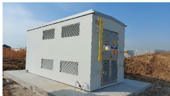
Figura 18: Cabina prefabbricata RE.MI.
