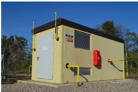
Figura 18: Cabina prefabbricata RE.MI.
